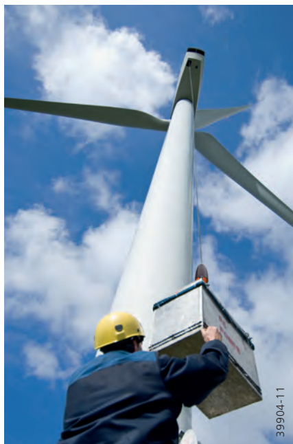
Course de crochet jusqu'à 180 m pour la maintenance d'éoliennes
