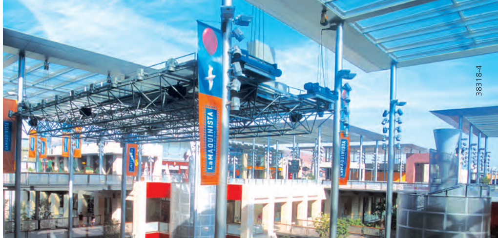
Mouvement de levage et de descente d'une construction de toit acier-verre avec 4 mécanismes de levage DH
