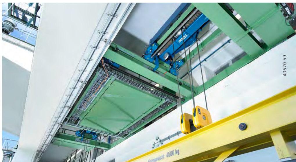
Les batardeaux sont positionnés avec 2 mécanismes de levage DH jusqu'à une profondeur d'eau de 22 m.
